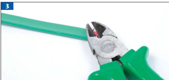
3 Schutzleiter mit dem Seitenschneider sorgfältig abschneiden.
