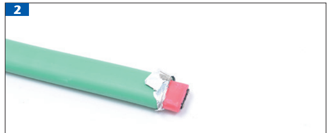
2 Schutzleiter zurückschieben und eventuell vorhandene Aluminiumfolie abtrennen.
