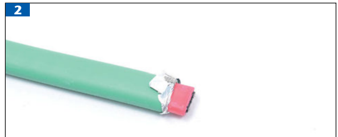
2 Schutzleiter zurückschieben und eventuell vorhandene Aluminiumfolie abtrennen.
