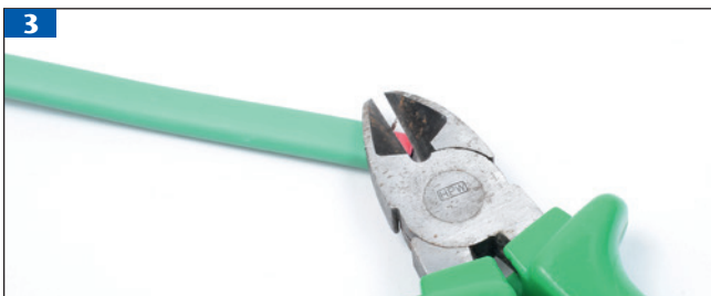
3 Schutzleiter mit dem Seitenschneider sorgfältig abschneiden.
