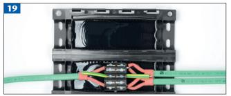
Klemmblock mittig in die Muffe einsetzen und eindrücken (Außenmantel der Heizbänder müssen innerhalb des Gels sitzen, Heizbänder nicht übereinander, sondern nebeneinander) und Muffe verschließen.
