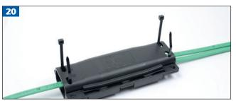
An beiden Seiten der Muffe je einen Kabelbinder durchschlaufen, festziehen und Überstand der Kabelbinder mit einem Seitenschneider abschneiden.
