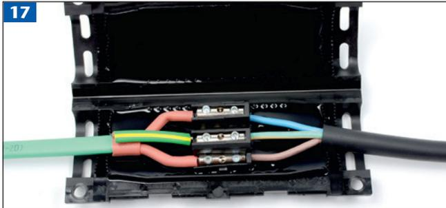
Klemmblock mittig in die Muffe einsetzen und eindrücken (Außenmantel des Heizbandes und der Anschlussleitung müssen innerhalb des Gels sitzen) und Muffe verschließen.
