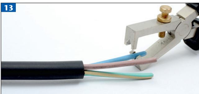
Alle Leiter mit der Abisolierzange auf 12 mm abisolieren.
