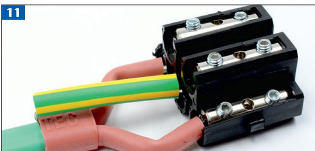
Vorbereitete Adern in den Klemmblock schieben (je einen stromführenden Leiter links bzw. rechts, Schutzleiter mittig) und Schrauben mit Inbusschlüssel festziehen.
