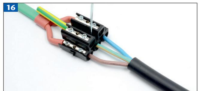
Verpresste Leiter in den Klemmenblock schieben (Außenleiter und Neutraleiter links bzw. rechts, Schutzleiter gelb/grün mittig) und Schrauben mit Inbusschlüssel festziehen.
