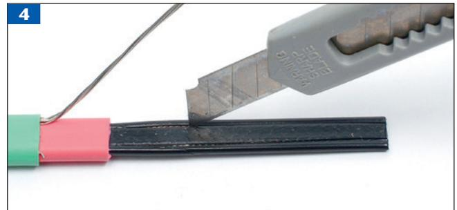
4 Schwarze Heizmatrix entlang der Kupferleiter an der Vorder- und Rückseite mit einem Kabelmesser aufschneiden.
