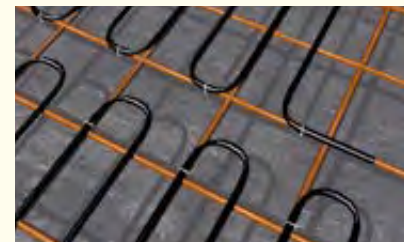
Heizmatte direkt verlegt auf oberer Bewehrung
