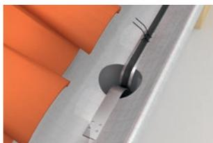
**Kantenschutz** am Fallrohr zur Zugentlastung.
