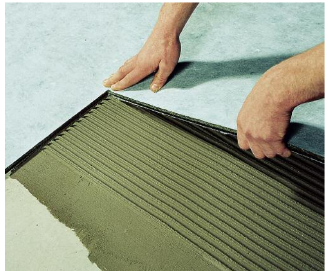
PCI Polysilent-Platten zur Trittschallminderung und zur Entkopplung von Keramik- und Naturwerksteinbelägen vom Untergrund.
