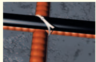
Befestigung des Heizkabels auf oberer Bewehrung mittels Kabelbinder
