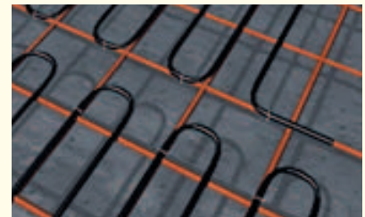
Heizmatte direkt verlegt auf oberer Bewehrung
