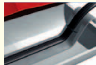
Kantenschutz am Übergang in die Dachrinne.
