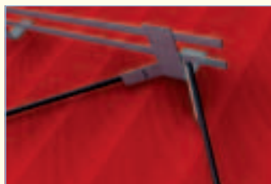
Kantenschutz an der Halterung des Schneefanggitters.
