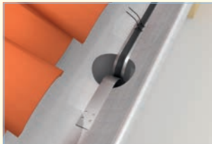
Kantenschutz am Fallrohr zur Zugentlastung
