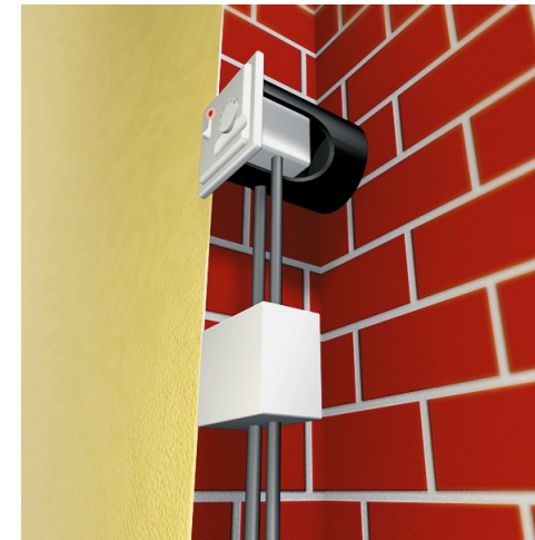
Regelgerät montiert in Schalterdose, Abzweigkasten für Temperaturbegrenzer
